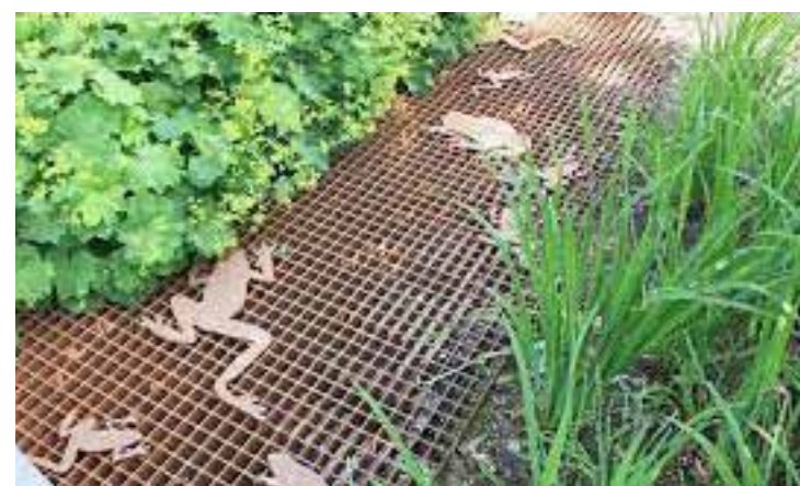
En lekfull och informativ design av en groddjurstunnel.
