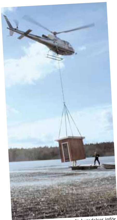
Under 2005 gjordes många förberedelser inför muddringen. Bland annat lyftes bodarna för miljökontrollen på plats med helikopter.
