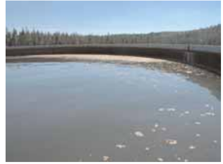
Returvattnet från geotuberna samlas i stora cisterner innan det renas och pumpas tillbaka till sjösystemet.
