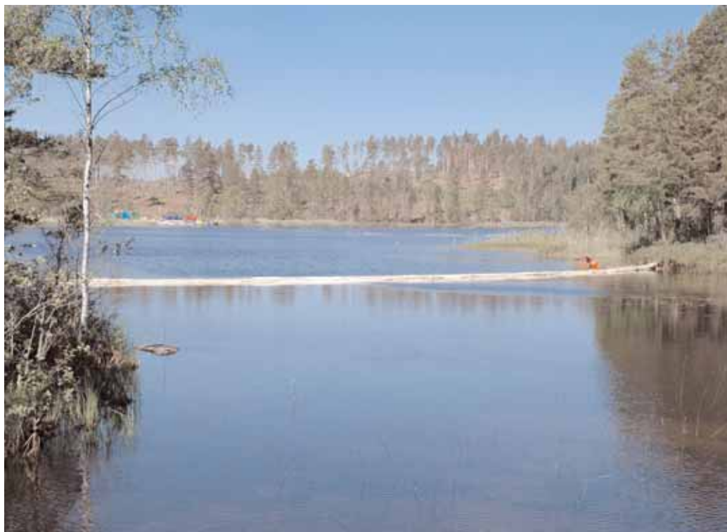
Under muddringen i Övre Svartsjön spärrades utloppet av med en textilskärm som fångar upp partiklar från muddringen.
