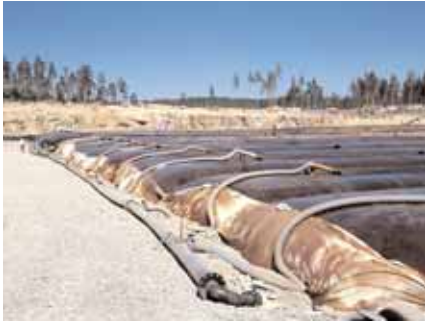
Muddermassorna från sjön kommer i den grova ledningen på bilden och trycks sedan via slangar in i geotuberna.
